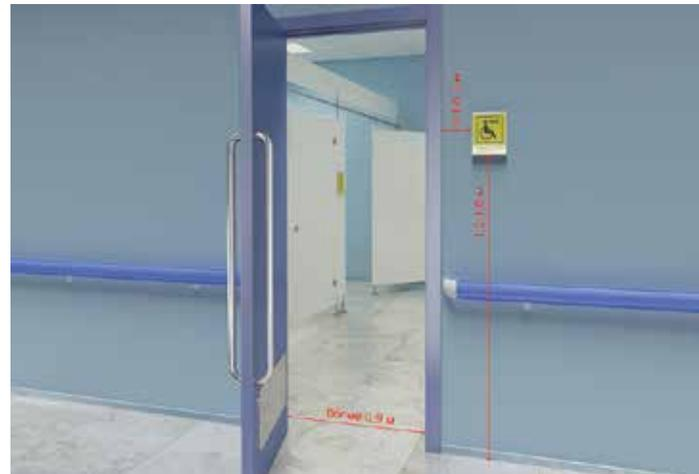
должна быть с автоматическим доводчиком и с дистанционным управлением от кнопки, расположенной вблизи зоны пересадки на унитаз. Одна из стандартных кабин в каждом блоке туалетов должна быть оборудована
